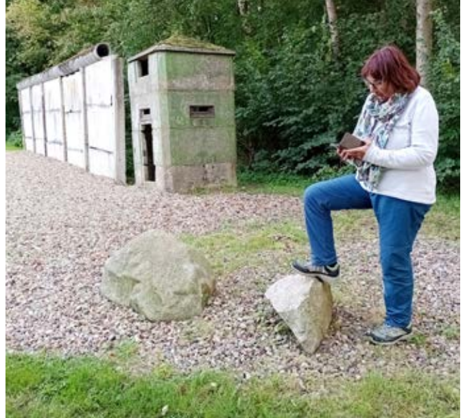
Mauerreste am ehemaligen Kolonnenweg zwischen Rade und Waddekath. Fotos: Dirk Marwede
